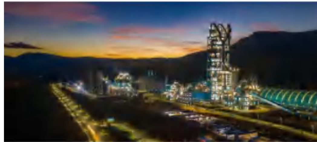
云南易门大椿树水泥日产4,000吨水泥熟料生产线
